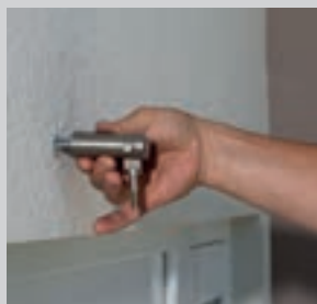
2 / Visser les fixations murales basses et fixer les pivots
