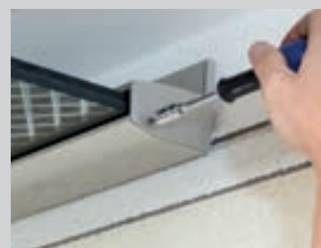
5 / Coller les embouts de finition et les visser.
