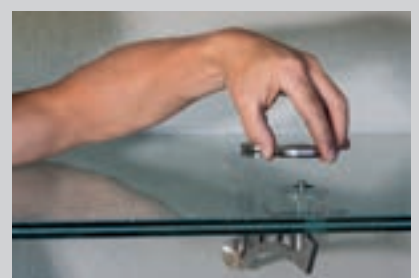
6 / Visser les caches supérieurs avec leur joint
