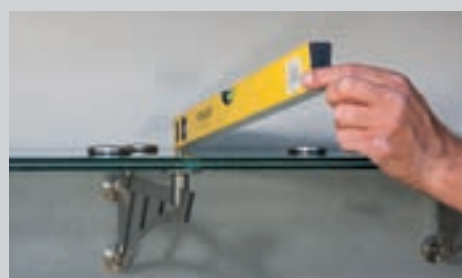
5 / Régler l'inclinaison
